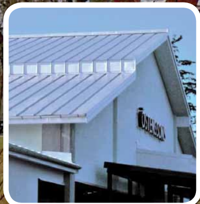
Östenssons i Vadstena taktäckning i Aluzink - Anders Pettersson - Christer Johansson
